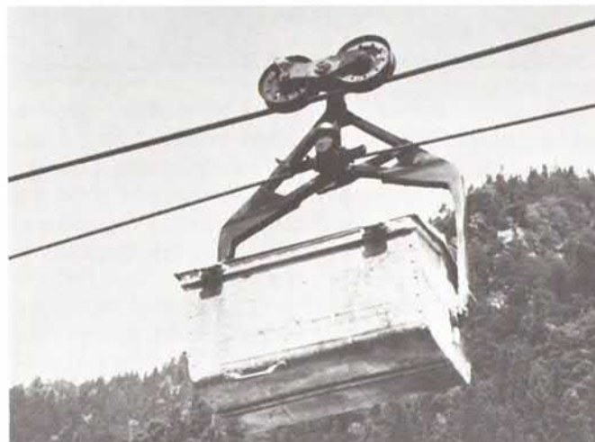
Abb. 9.4 Zweiseilbahn für den Transport von Lasten
