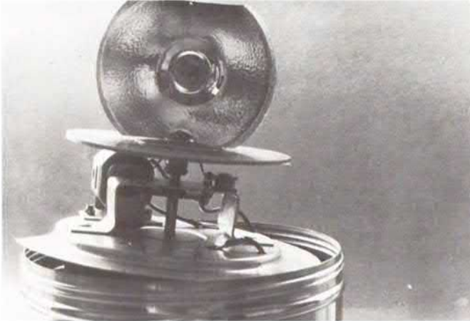
Abb. 16.12 Ein Elektromotor dreht eine Scheibe, auf der Reflektor und Birne sitzen
